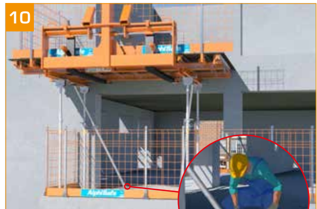
- Schrägstützen verankern.
