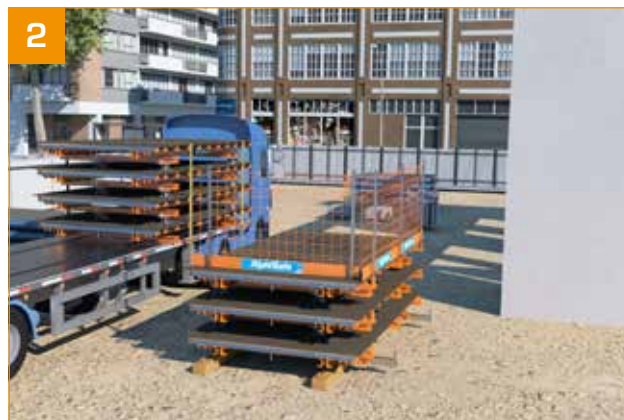
2 - Schalungstisch gemäß des mitgelieferten Schalungsplans mit dem AlphaSafe-Schutzsystem ausstatten.
