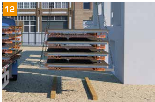
- Stapel auf Kanthölzer absetzen, Kran lösen und Hebebalken entfernen.
