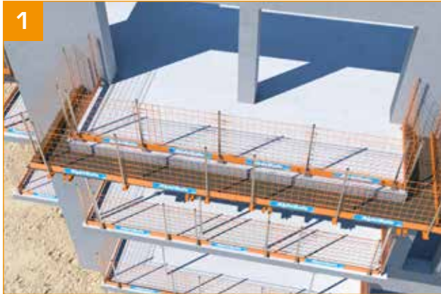
1 - Nach dem Betonieren und Absichern des Balkons mit dem Ausschalen beginnen.
