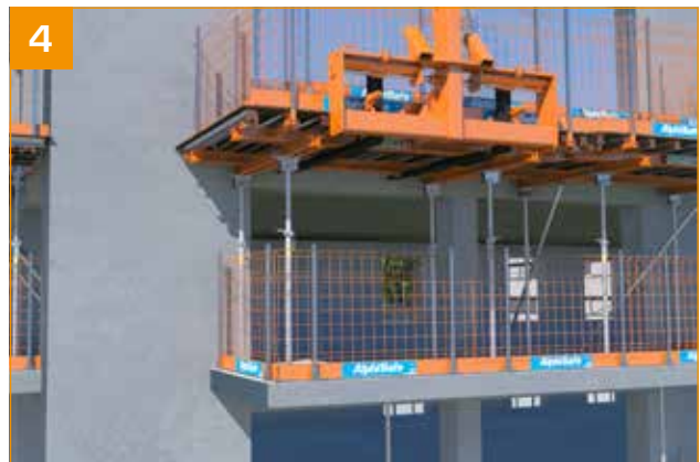
4 - Schrägstützen entfernen.
