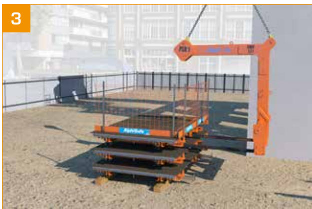
3 - Obersten TopTable Schalungstisch mit der Lasttraverse oder den Hebebalken aufnehmen.
