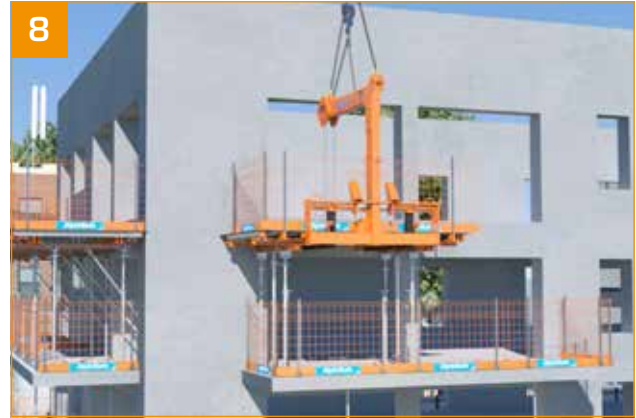
- TopTable Schalungstisch auf der gewünschten Schalungshöhe montieren.
