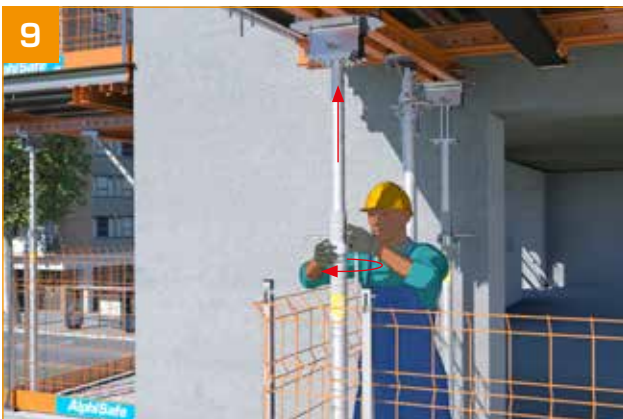
- Innenrohr der Stütze bis zum Anschlag gegen den Stützkopf des Tisches herausdrehen. - Stütze in dieser Position mit dem Sicherungsstift blockieren. Mutter anziehen. - Vorgang für alle Stützen wiederholen.
