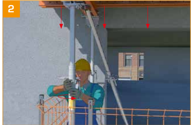
2 - Die Muttern der Stützen lösen, um den Schalungstisch 3 bis 5 cm abzusenken.
