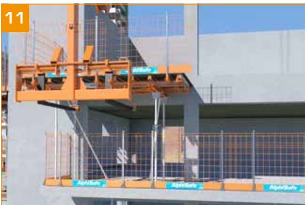
- Lasttraverse entfernen.
