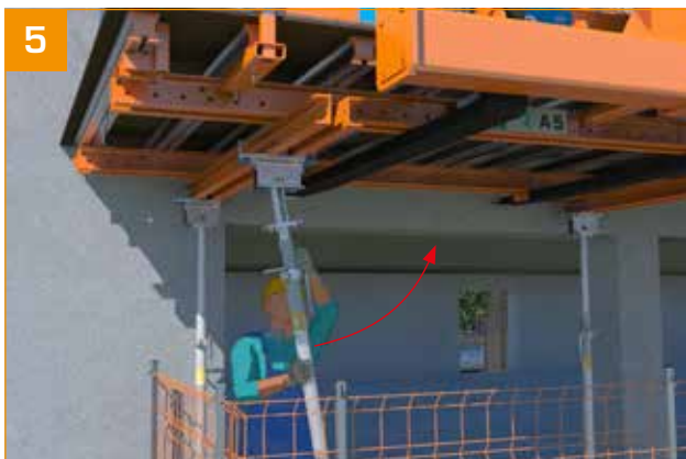
5 - Außenrohr der Stütze einfahren. - In eingefahrener Position verriegeln. - Stützen einklappen. - Vorgang für alle Stützen wiederholen.
