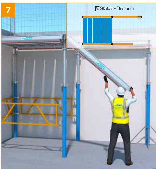
- Anbringen eines Hauptträgers auf einer stabilisierten Schalungsstütze (ST).
