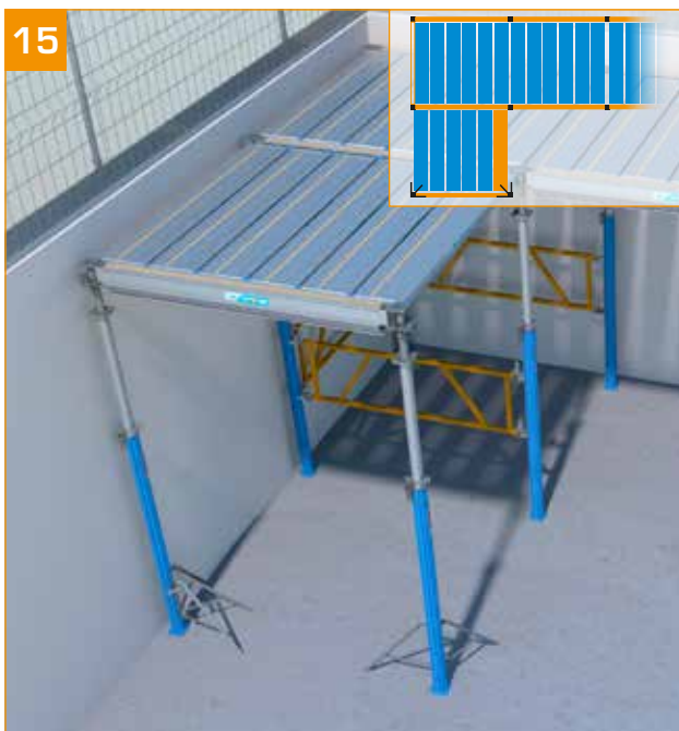
- Mit der Installation der Eco+ Paneele fortfahren.
