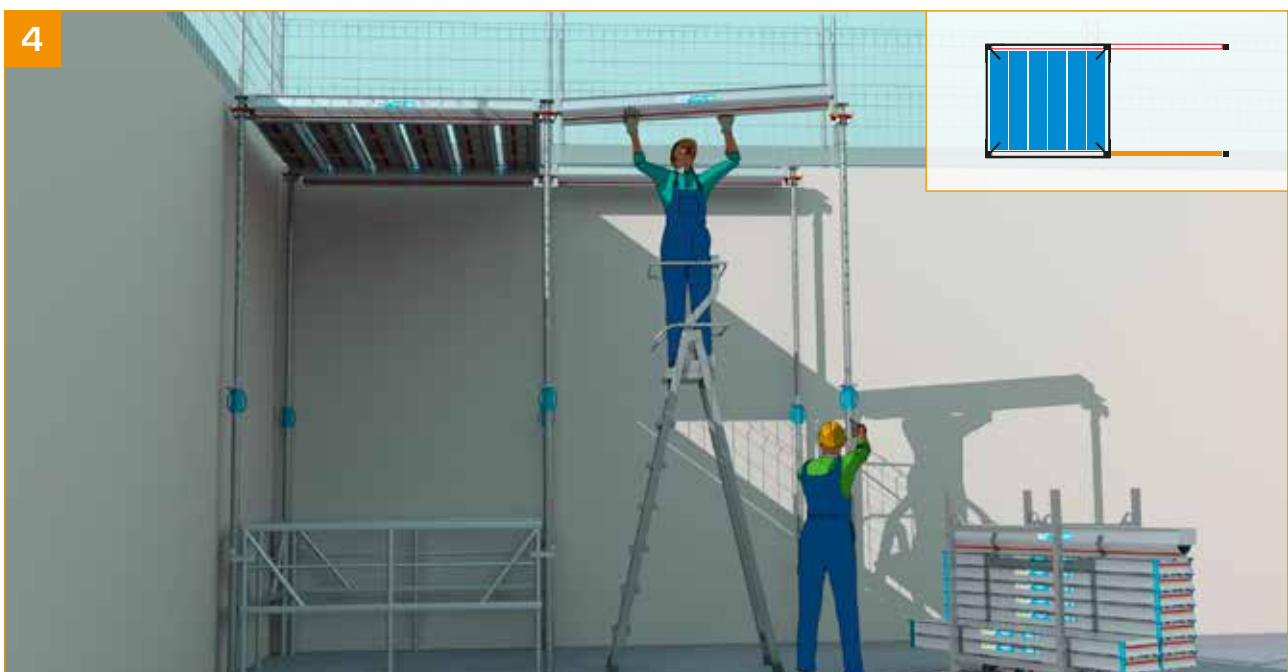
- Die Hauptträger und Eco+ Paneele während des Baufortschritts erneut aufstellen.
