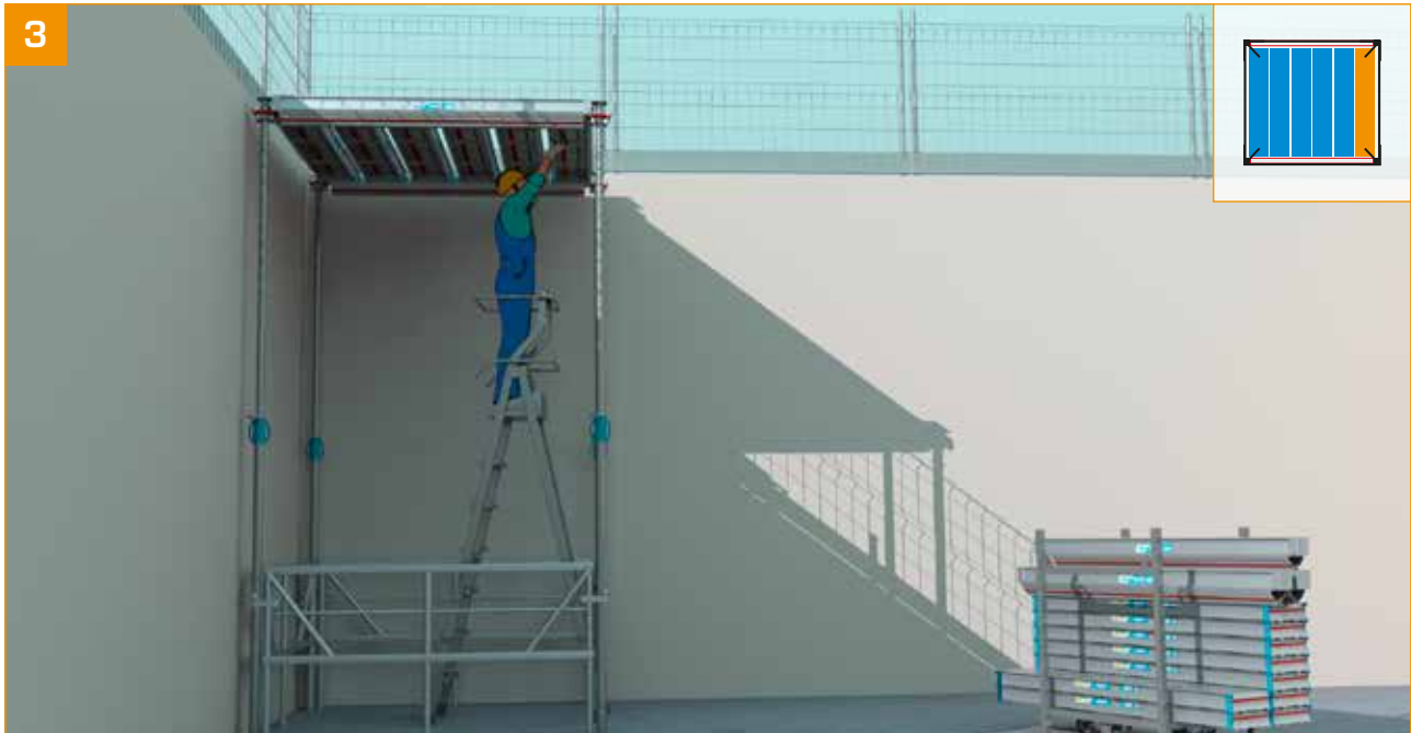
- Die Installation der Eco+ Paneele abschließen.
