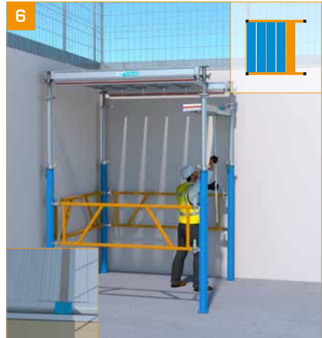
- Nach und nach die Eco+ Paneele mithilfe der TopPerche-Stange verlegen. - Die Paneele aneinanderfügen. - Es bleibt ein Spalt von 2 cm.
