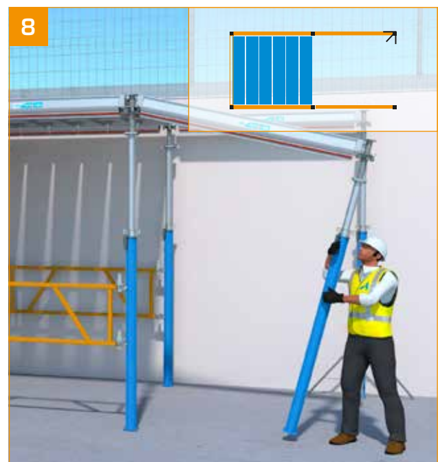
- Der Monteur verwendet die Stütze, um den Hauptträger zu platzieren.
