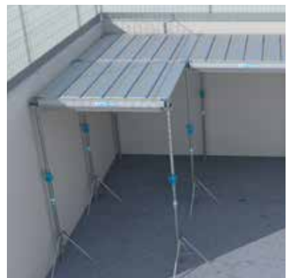
Die ausziehbaren Träger ermöglichen eine bessere Anpassung an die Randbereiche des Abschnitts
