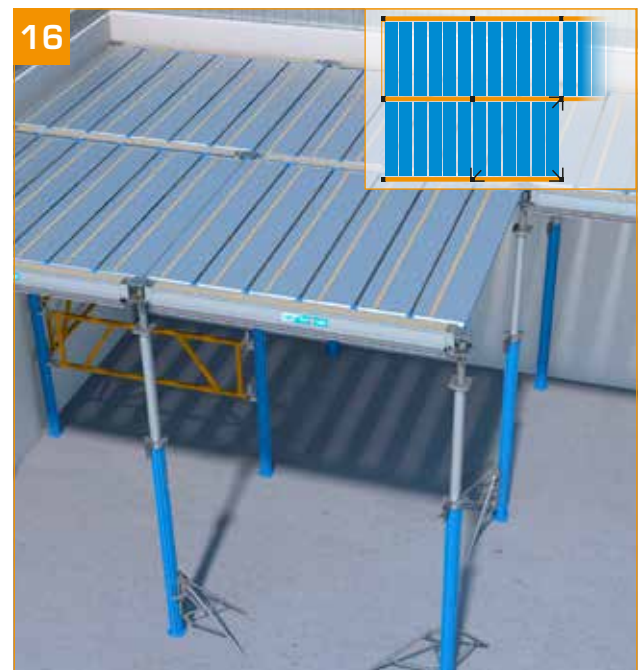
- Die Eco+ Paneele mithilfe der TopPerche-Stange nach und nach weiter verlegen.
