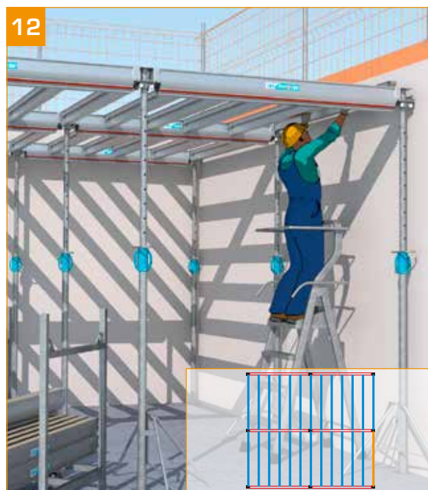
- Alle Nebenträger für diesen Abschnitt installieren.
