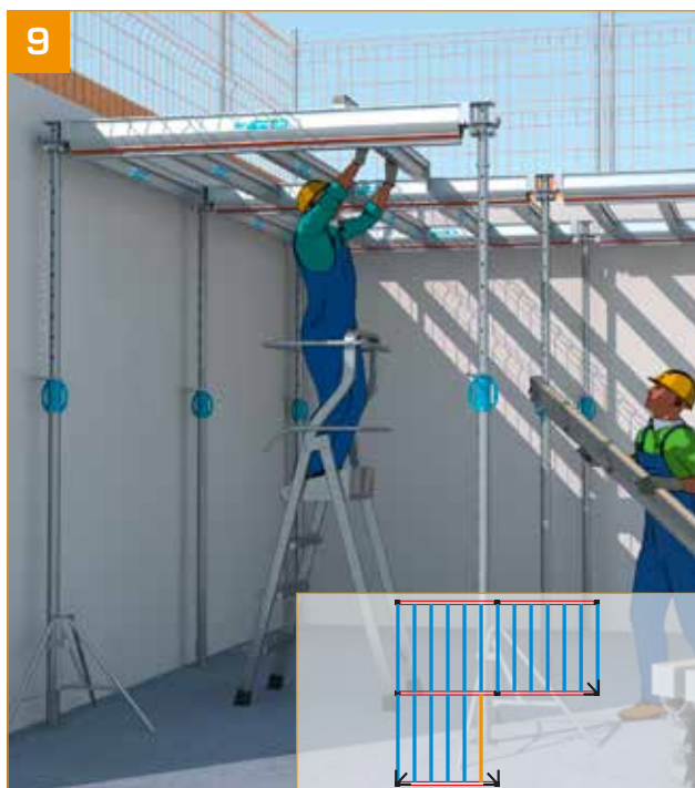
- Stück für Stück mit der Installation der Nebenträger fortfahren.
