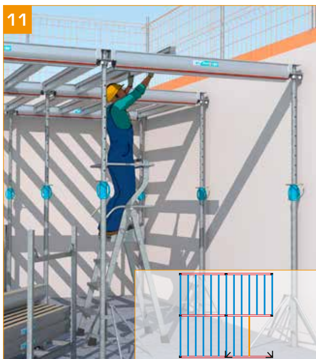
- Stück für Stück mit der Installation der Nebenträger fortfahren. Dabei einen Abstand von 39 cm nicht überschreiten.
