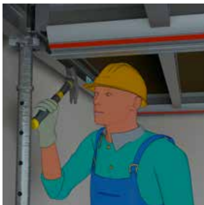
La tête coffrante à décoffrage rapide intégrée permet une rotation accélérée de la structure aluminium
