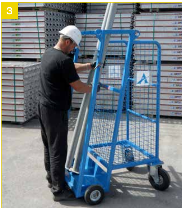
- Ausrichten der Stützen im Transportgestell.
