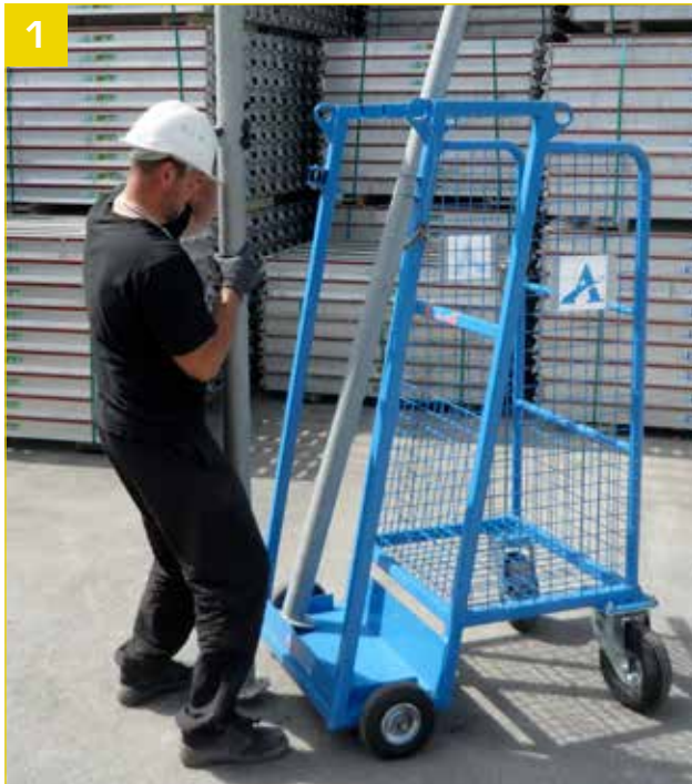
- Antransport der Stützen in aufrechter Position.
