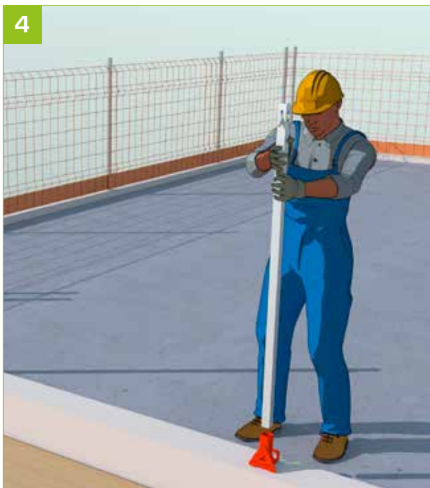
- Mettre en place les potelets.
