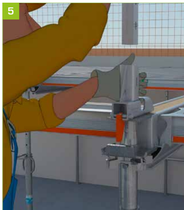
- Mettre le potelet AlphiSafe dans l'adaptateur.
