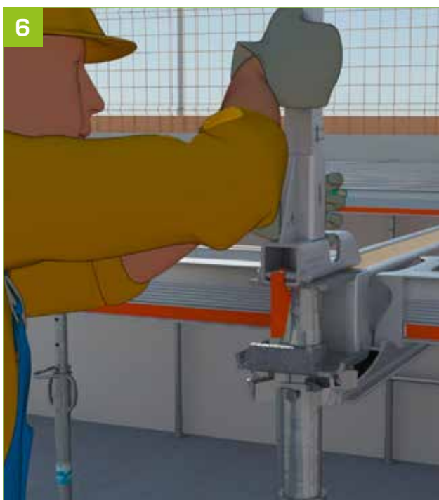
- L'anti-déboitement du potelet se verrouille automatiquement sur l'adaptateur.
