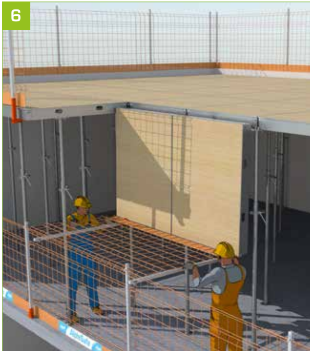
- Mettre en place la grille AlphaSafe.
