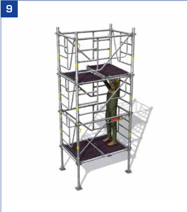
- Versetzen des zweiten Durchstiegslements von der unteren Ebene aus.
