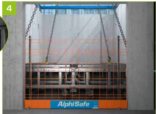
4 - Soulever le Podium pour mettre en place les rochets dans les réservations murales.
