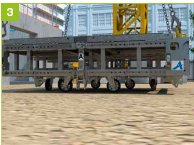
3 - Poser le Podium au sol sur ses roulettes.
