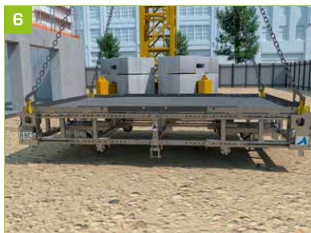
6 - Élinguer le Podium pour mise en place dans la trémie.
