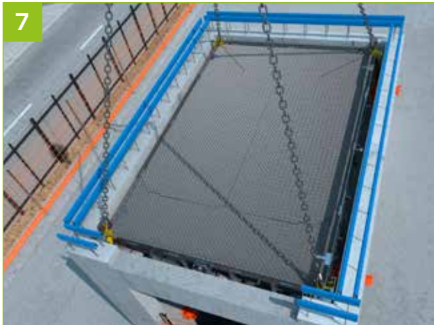
7 - Les clapets se déplient automatiquement et le Podium passe au-dessus.
