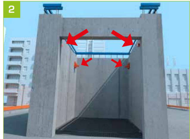
- Les claps sont insérés dans les réservations depuis l'intérieur de la cage.
