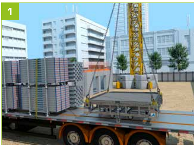
1 - Élinguer le Podium grâce aux 4 crochets de levage rétractables.
