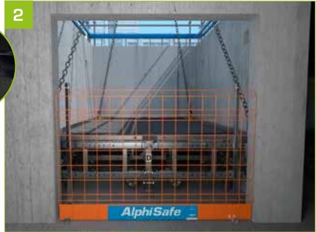
2 - Poser le Podium au fond de la trémie à sécuriser.
