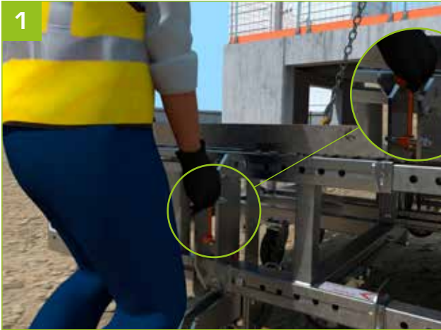
1 - Au sol, mettre le rochet en position bloquée grâce à la tige de blocage.
